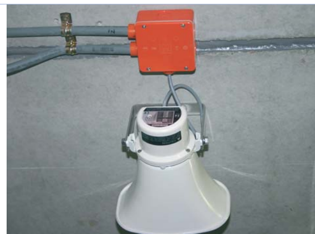
Bij bevestiging van een FB-installatie direct op het beton moeten stalen pluggen worden gebruikt.
